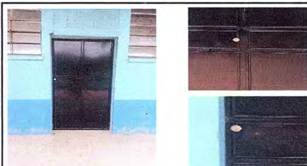
Foto 4: Las Chapas de las puertas ya arregladas y nuevas
