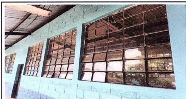
Foto 3: Los vidrios de las ventanas de las aulas ya colocados
