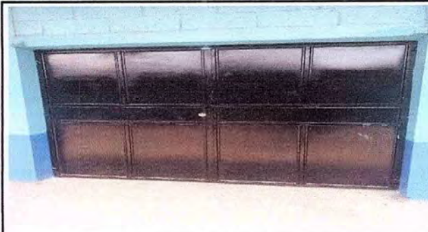
Foto 2: Las puertas de aulas y el salón ya terminadas en su totalidad
