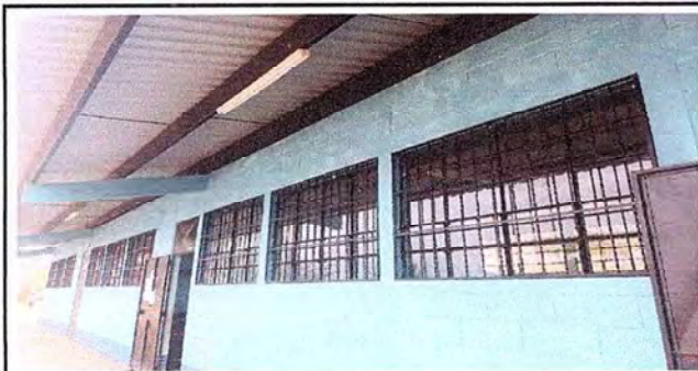
Foto 1: Los balcones están al 100% colocados
